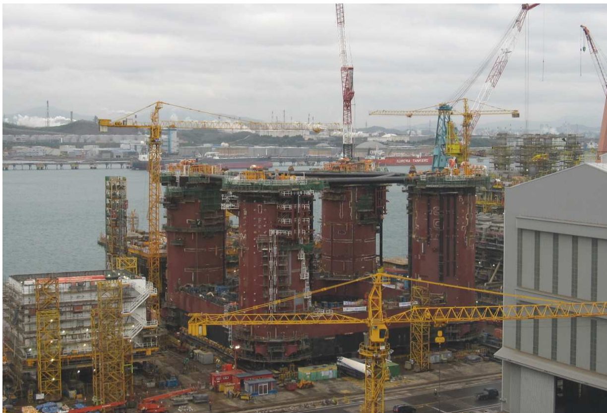
Vue de la coque de la TLP (Tension Leg Platform) Moho Nord sur le chantier de Hyundai Heavy Industries – Cette TLP sera installée sur le champ de Moho Nord (Total E&P Congo) au large de la République du Congo
