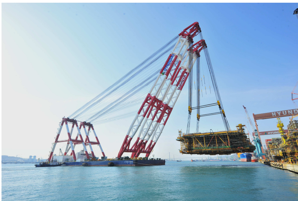
Vue de la barge de levage Hyundai Heavy Industries avec le pont de la TLP (Tension Leg Platform) Moho Nord – Cette TLP sera installée sur le champ de Moho Nord (Total E&P Congo) au large de la République du Congo
