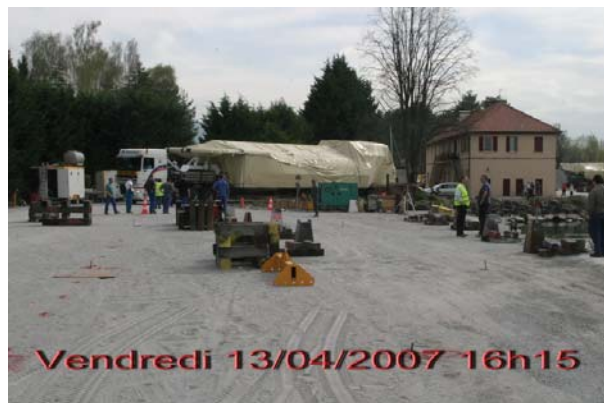
Dépose des modules sur l'aire d'assemblage
