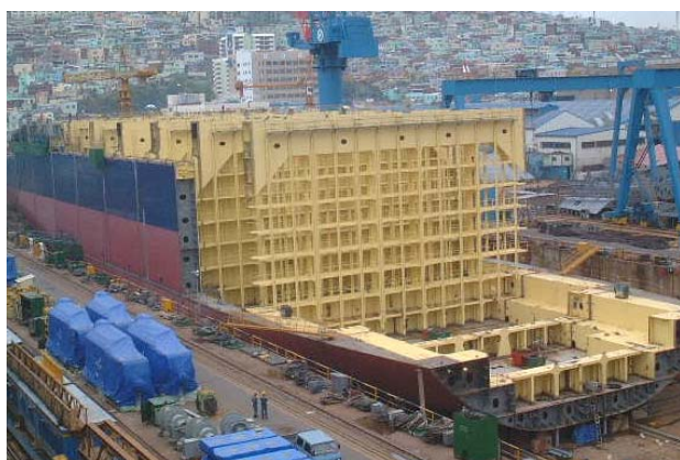
6 500 Evp en construction, chantier Hanjin, Corée du Sud – photo CMA CGM
