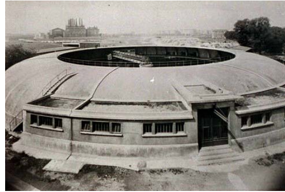
Figure 3.3a: Vue extérieure du bassin de giration avant qu'il ne soit couvert en 1953
