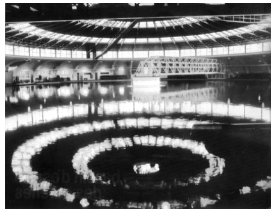
Figure 3.3b : Vue intérieure du bassin de giration après la pose du toit en verrière
